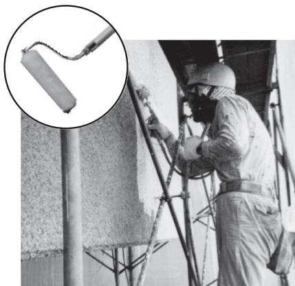
EP・NED塗料の天井・内装施工
