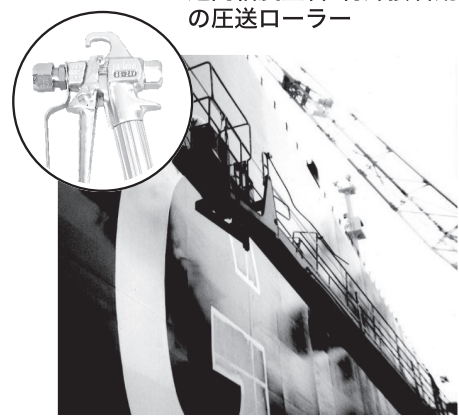
重防蝕塗料のエアレス吹き
